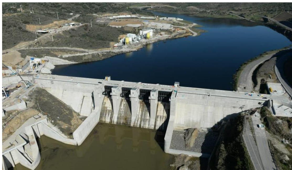
Figura 3 – Aspecto do Escalão Jusante (Junho 2014)
