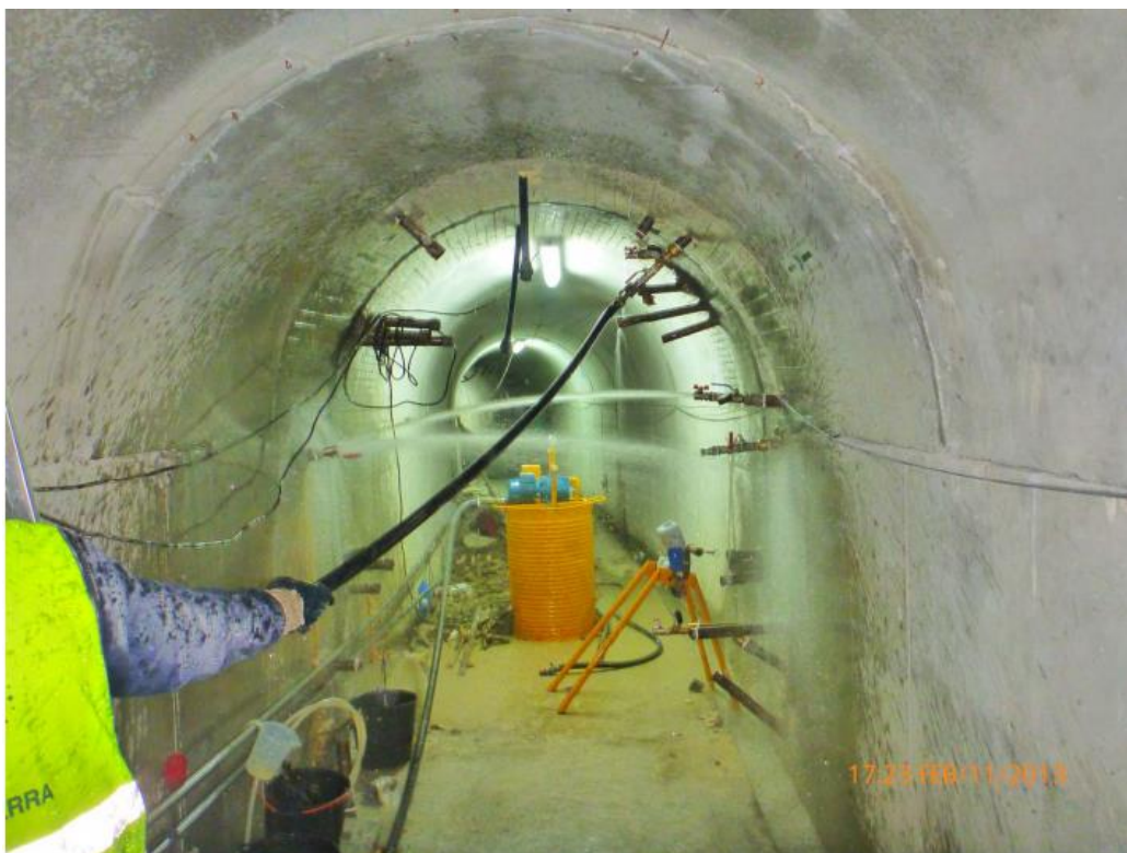
Figura 12 – Aspecto do Ensaio de Água numa junta
