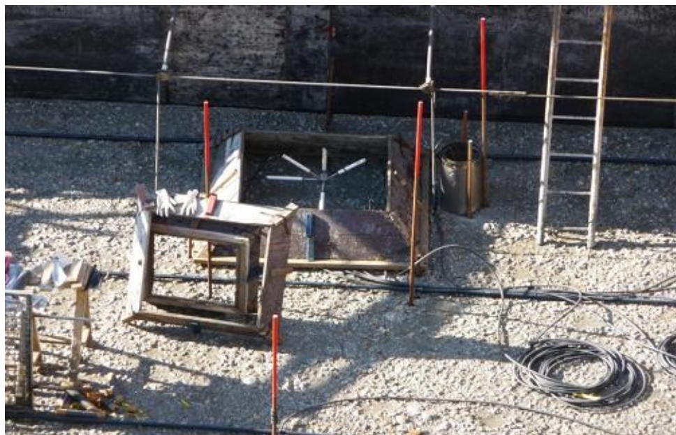
Figura 13 – Pormenor de montagem de uma roseta antes da betonagem
