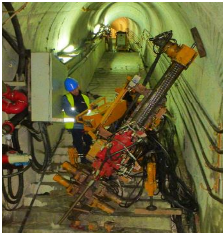
Figura 7 – Equipamento tipo Beretta T43 durante a execução de perfurações para Consolidação
