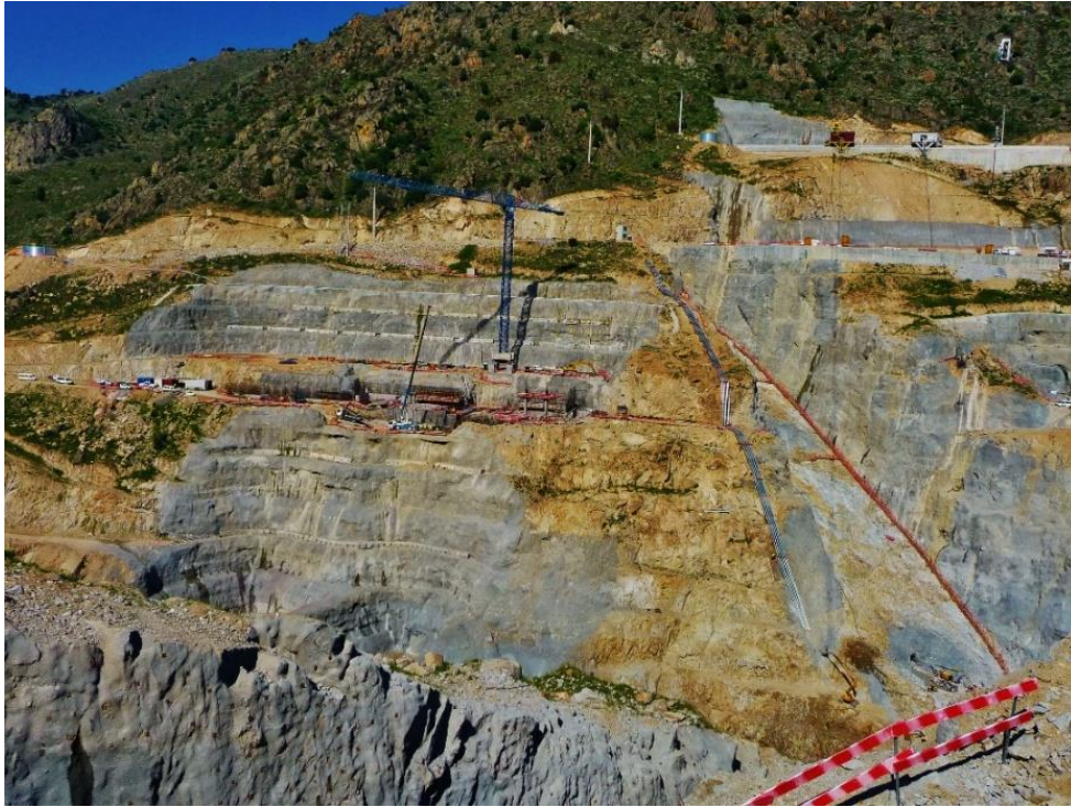
Figura 4 – Aspecto da Margem Direita do Escalão Montante (Abril 2011) com vista das Contenções na Barragem, Central, Restituição e Cais e Blondin
