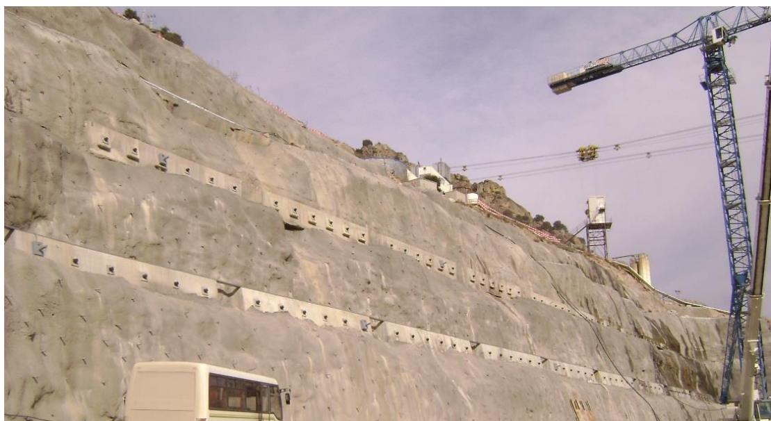
Figura 5 – Contenção para construção da Central Eléctrica do Escalão Montante
