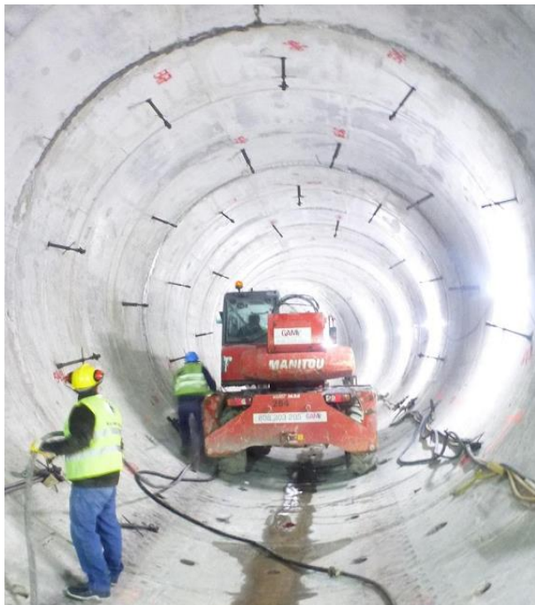
Figura 10 – Pormenor da colocação de obturadores durante a fase de injeção na obra subterrânea
