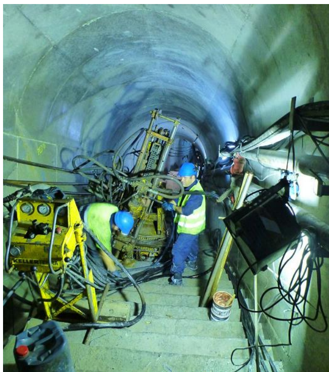
Figura 9 – Equipamento tipo Diamec durante a execução de perfurações para a cortina de Impermeabilização
