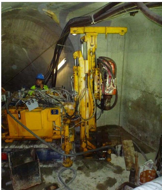
Figura 16 – Equipamento “Terra” executando o alargamento do furo-guia de um Fio-de-Prumo
